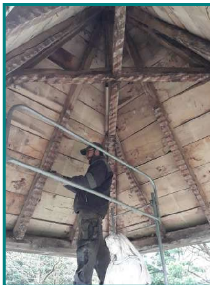
Lasure de la charpente
