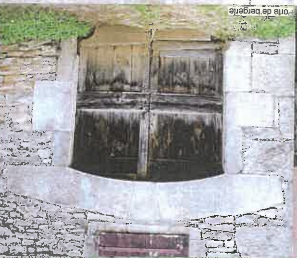
Arc de décharge et linteau en arc surbaissé en grès rouge monolithique ou la date 1849
