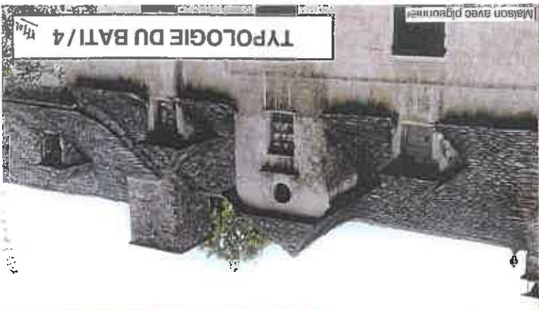
Colure dite à la "Mansart", encadrement des lucarnes en pierre de taille
