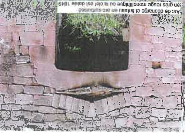
Arc de décharge et linteau en arc surbaissé en grès rouge monolithique ou la date 1849
