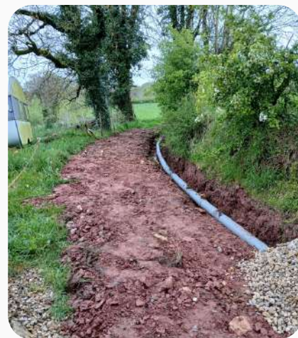
Mise en place d'un drain pour évacuer les eaux de pluie du Chemin de La Fon
