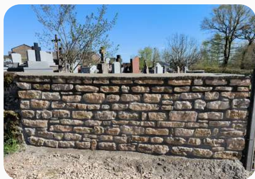
Réfection du mur du cimetière, réalisée par les employés communaux
