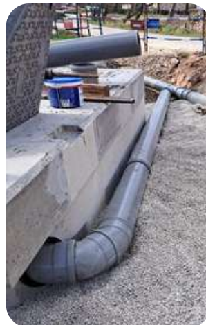
Réalisation du réseau pluvial en amont du lavoir de St Julien de Rodelle
